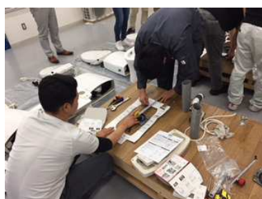
便器設置研修
