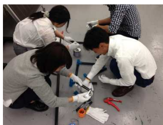
配管施工研修
