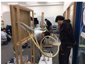
エアコン施工研修
