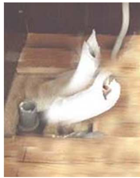
画2 床から配管
