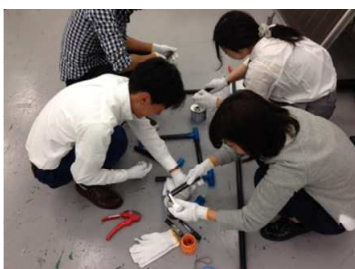
配管接続研修
