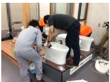
便器設置研修
