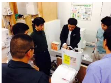
便器WL設置研修
