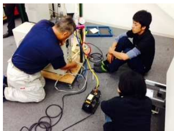
エアコン施工研修
