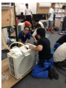
エアコン施工研修
