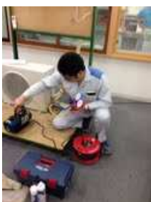
エアコン施工研修
