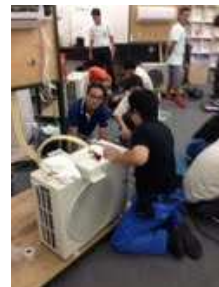
エアコン施工研修
