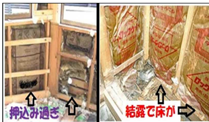
画2 断熱材施工不良結果
