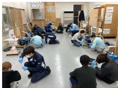
エアコン施工研修
