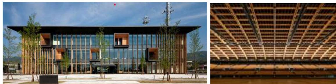
\* 木造建築物は集成材による構造躯体強化により大規模化が進んでいます。杉などの間伐材や歪みのあるカラマツなどの森林資源の循環利用が、地球温暖化防止やSDGSにつながっています。
