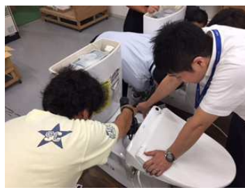
便器設置研修
