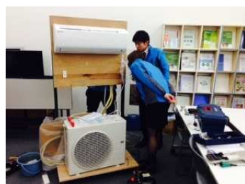
エアコン施工研修
