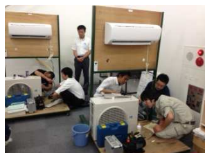
エアコン施工研修
