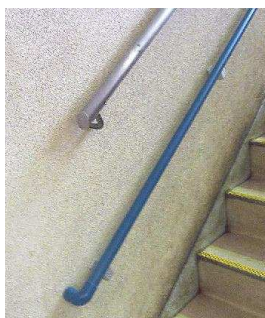
画1 階段手すり
