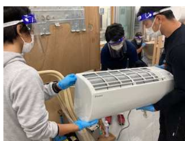
エアコン施工研修
