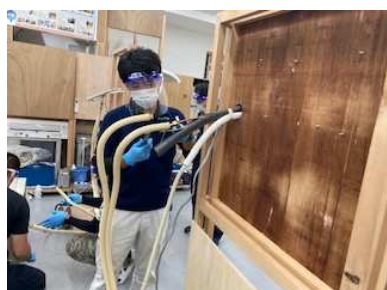
エアコン施工研修
