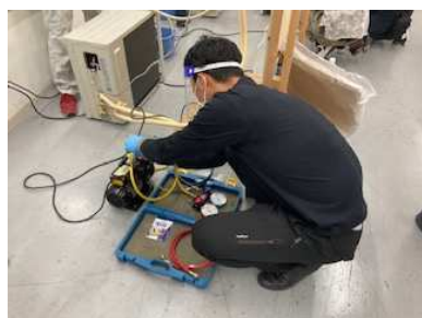
エアコン施工研修
