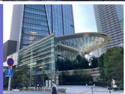
森タワー2014 ビジネスタワー2020 ステーションタワー 2022（建設中）
