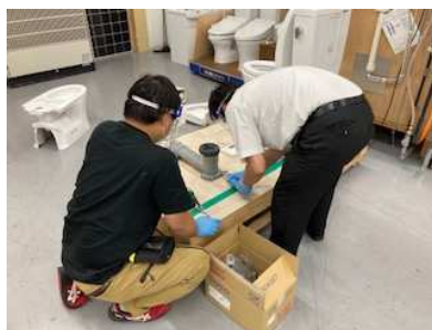
便器設置研修
