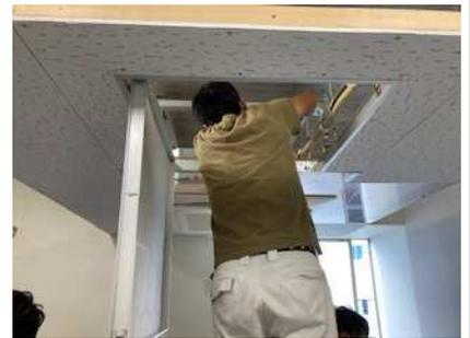
パッケージエアコン施工研修室では、点検口から天井裏ドレン配管の結びを実習できます。
