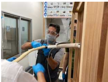
エアコン施工研修
