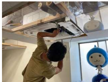
パッケージエアコン施工研修
