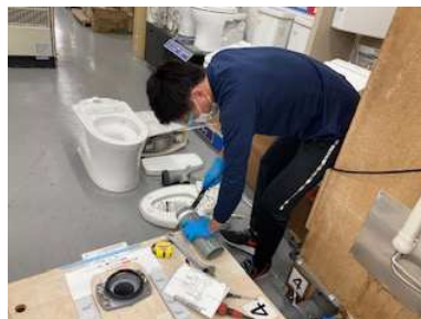
便器設置研修
